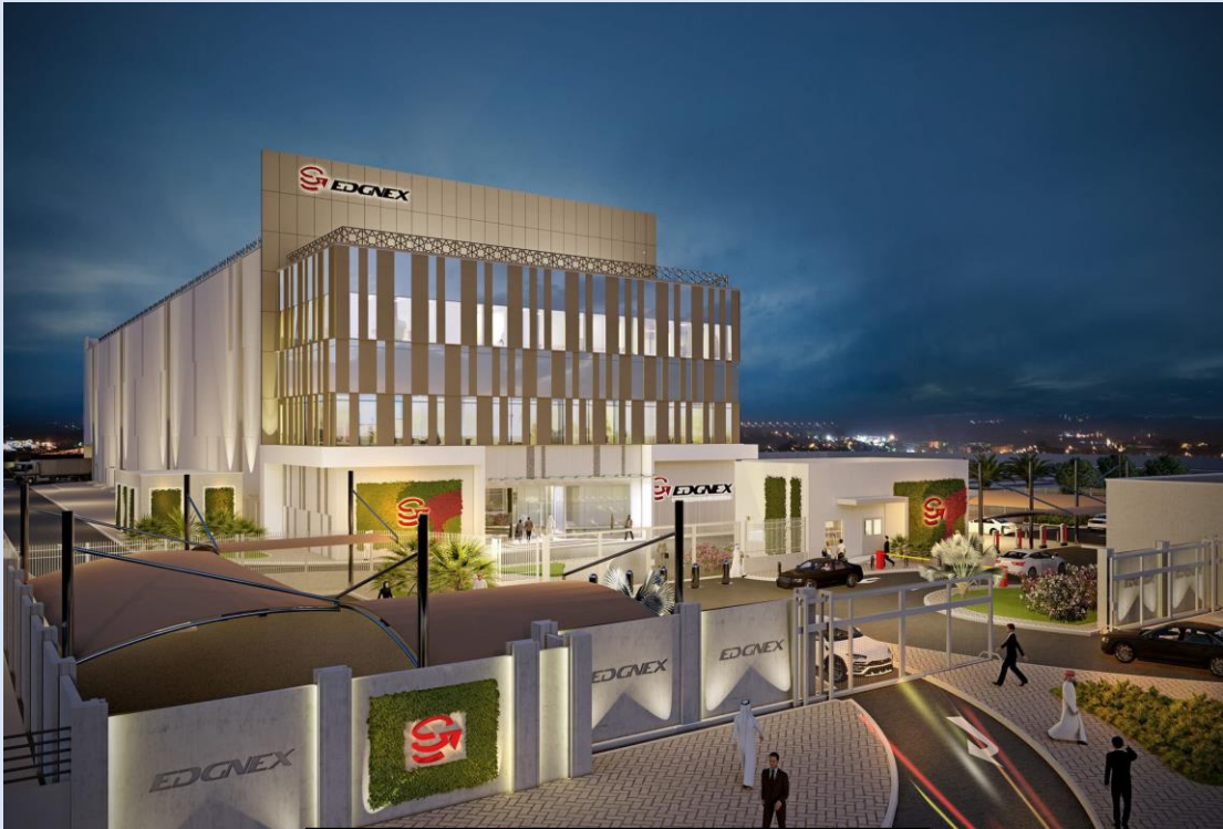
EDGNEX DATA CENTER (SPARK)
