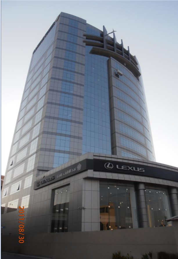
Al Kifah Tower
